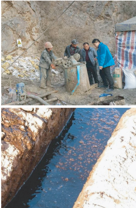
图5 聚合物泥浆的现场配置
