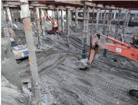
图9 降水方案调整实施后的开挖效果
