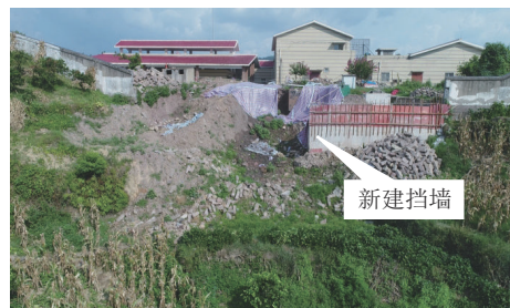
图2 新建长度11.4 m的衡重式挡墙
