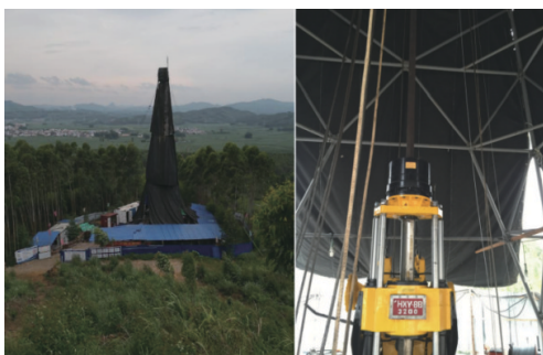
图2 桂柳地1井施工现场
