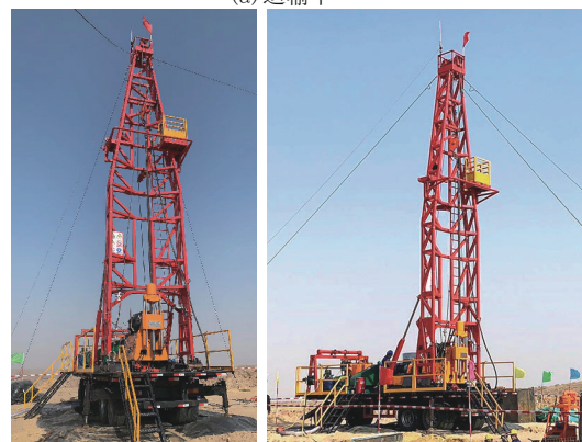
(b) 施工现场
