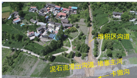
图4 2021年6月泥石流淤积情况
