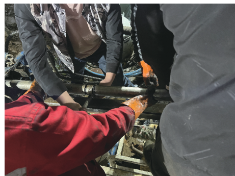
(b) 仪器出井作业
