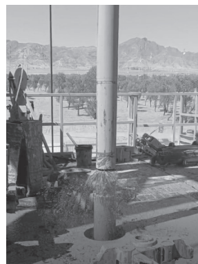
图 4 螺杆钻具试运转照片
