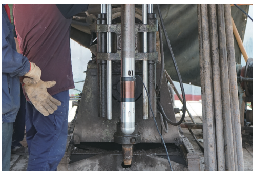
图5 地应力监测仪器安装
