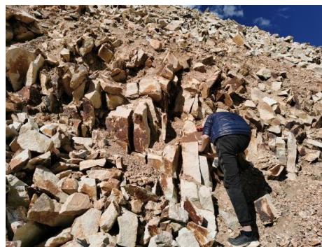
图7 边坡岩体裂隙发育
