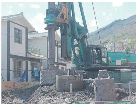
图5 XR420型钻机A3-7试桩
