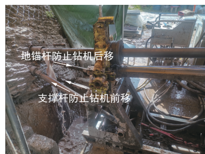
图5 水平机架前后移动固定
