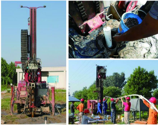
图1 SonicSampDrill CRS-V型声波钻机及CMT监测井成井工艺
