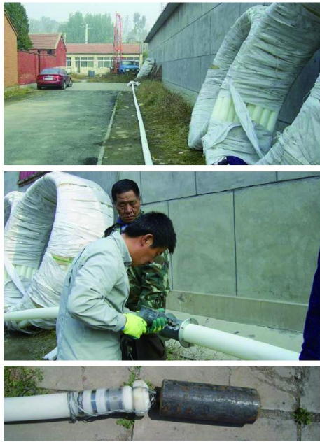
图 5 连续多通道管材入井前准备工作
