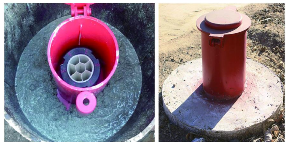
图 8 现场安装孔口保护装置
