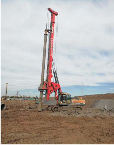
图1 旋挖钻机成桩
