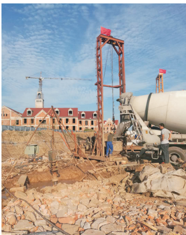
图 4 回转钻机成桩
