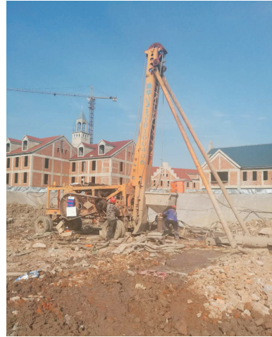
图2 冲击钻进成桩
