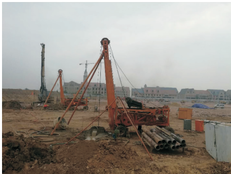
图 3 现场冲击钻进清孔
