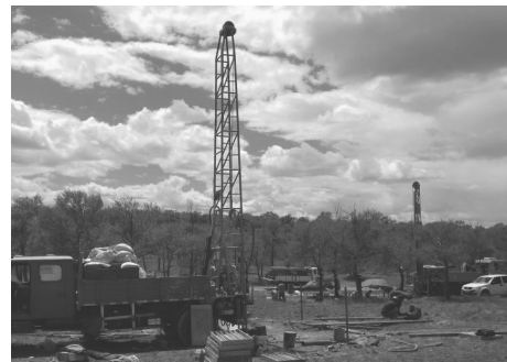
图10 以钻代槽技术方法试验施工现场
