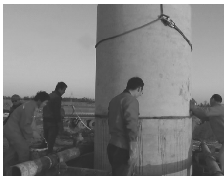
图 4 下水泥护筒图
