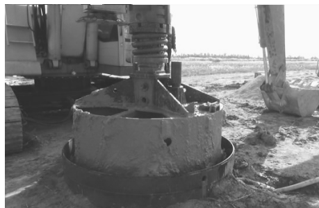
图 3 集水井施工图
