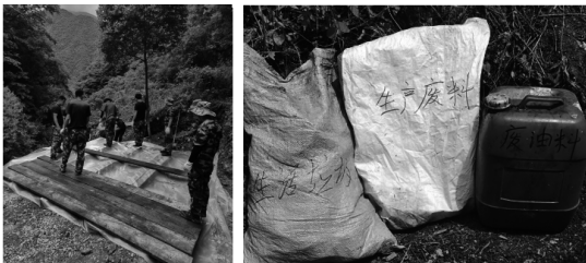
(c) 机台铺设防渗薄膜 (d) 固体垃圾和废油脂收集
