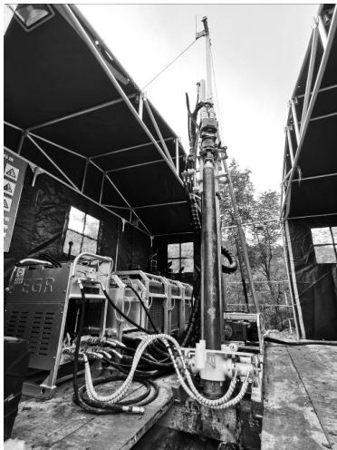
图1 EP600/EP600plus型模块化钻机在秦岭工作区施工作业
