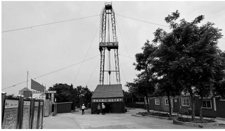
图1 钻探施工现场
